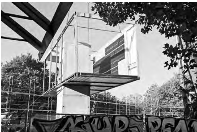
„Es muss passen!“ Das Modul wird über den Schornstein gestülpt.
