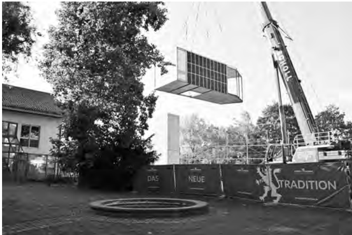
Modul wird hochgezogen und auf die entsprechende Position gesetzt.
